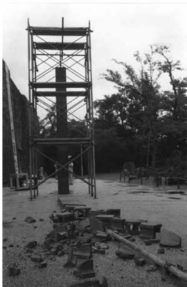
図 54 コンクリートブロック発射台 (第 33 回高知市展、高知県立郷土文化会館前、1981 年 6 月 13-21 日)
